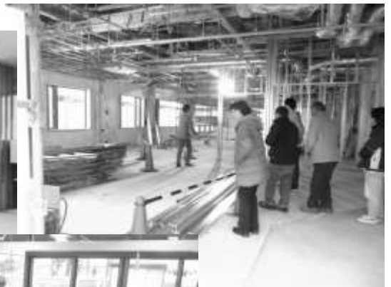
工事中の現場
